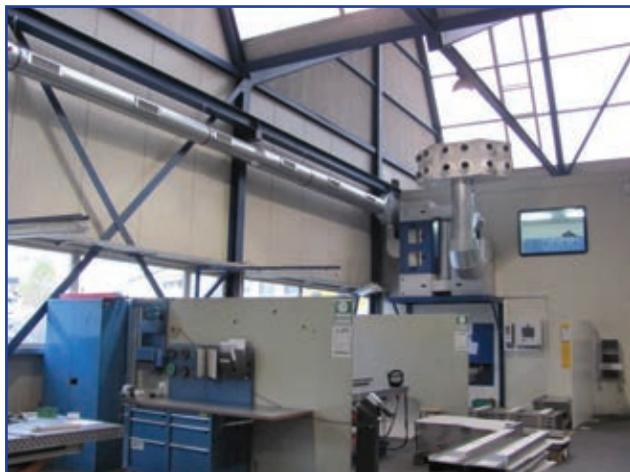
Энергоэффективность и универсальность — это особенности фильтровентиляционной системы AIRTECH – BlowTec. Модульная конструкция позволяет применять AIRTECH – BlowTec в тех производственных помещениях, в которых невозможно размещение любой другой вентиляции. Стандартные элементы системы могут быть размещены в любом порядке, что позволяет установить ее в ограниченном пространстве и в помещениях с низкими потолками.
