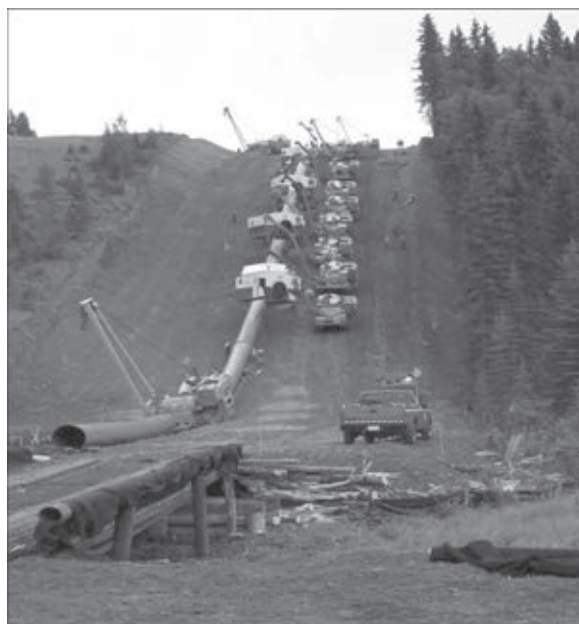
Рис. 4. CRC колонна на трассе
