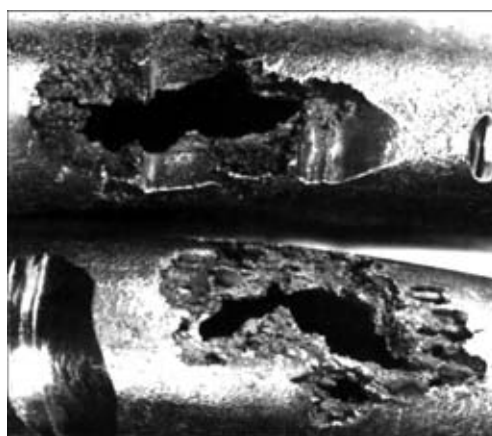
Рис. 1. Внешний вид поврежденных змеевиков ПВД-6
