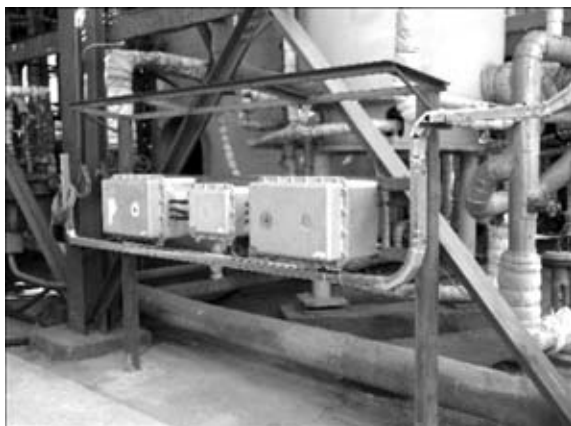
Рис. 2. Приборы ЕМА ЗС для контроля оборудования и трубопроводов цеха производства аммиака
