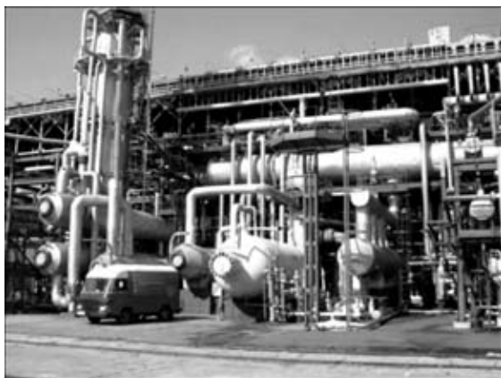
Рис. 3. Общий вид цеха производства аммиака
