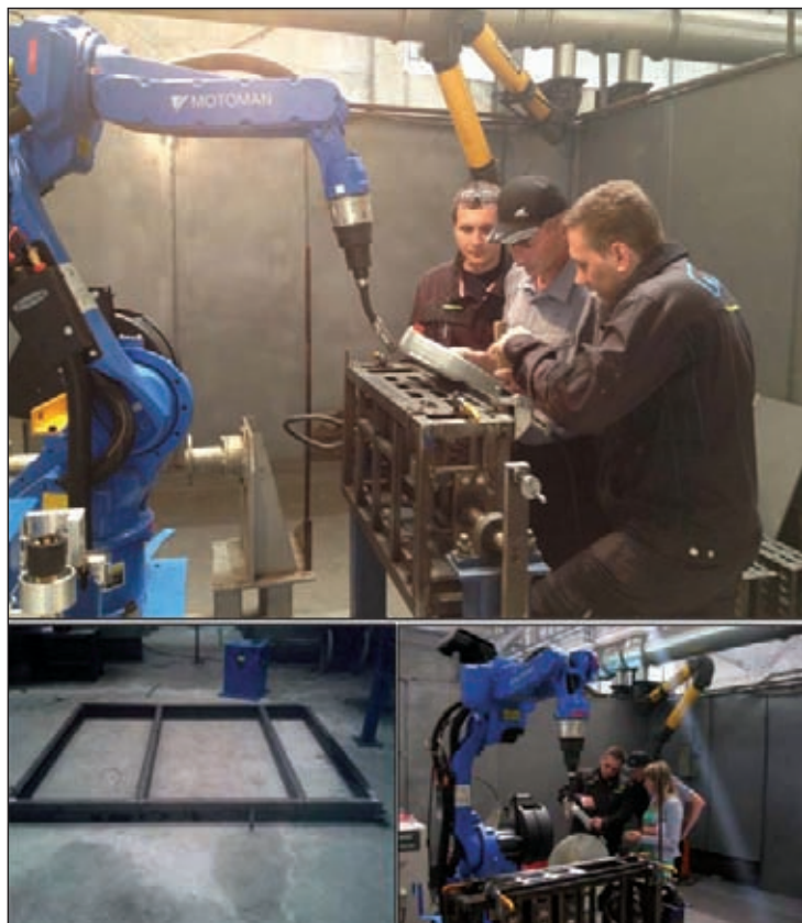
Монтаж роботизированного комплекса MOTOMAN на производственной площадке
