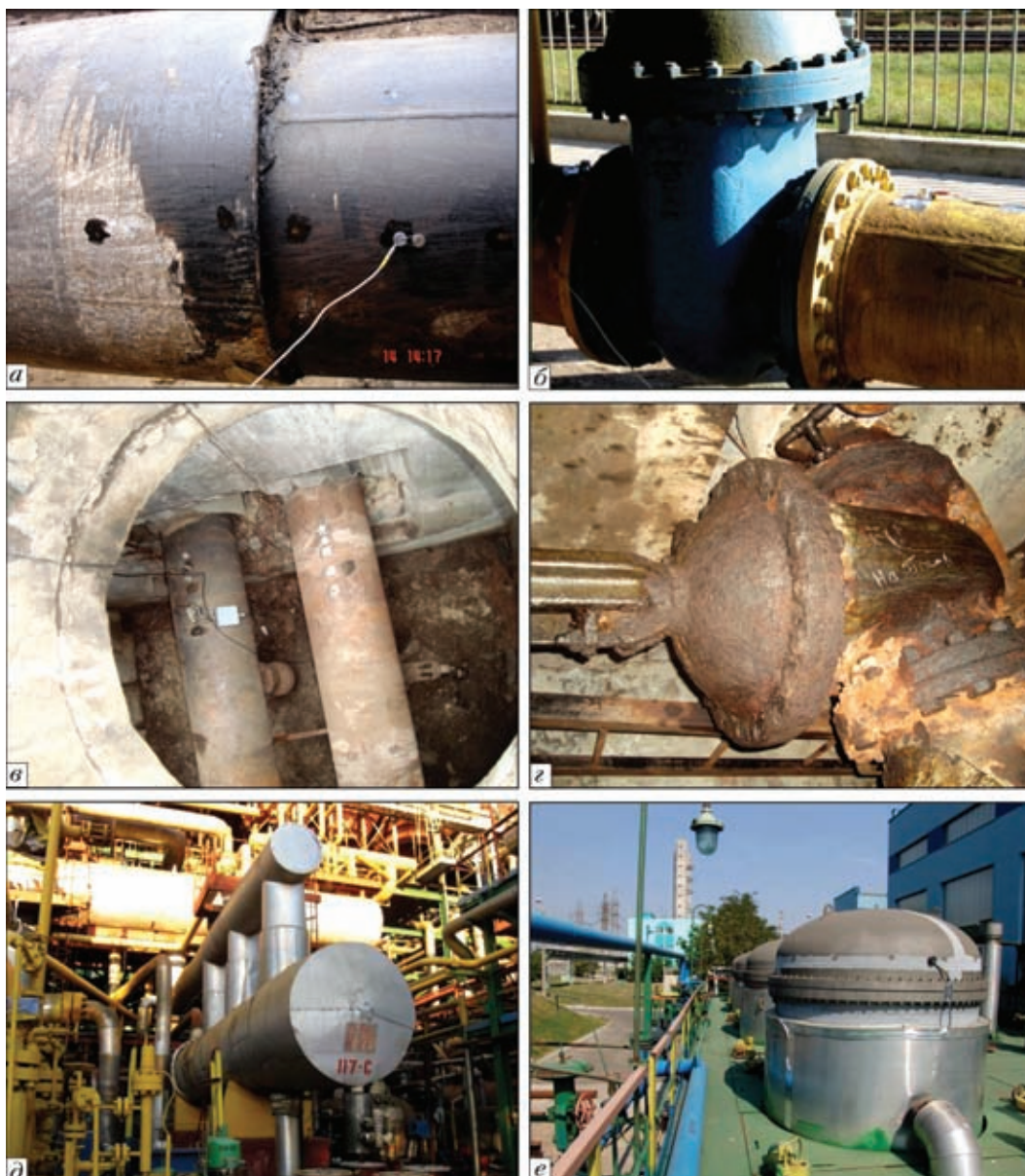
Рис. 5. Обследование подземного перехода газопровода «Ефремовка–Диканька–Киев» диаметром 1020 мм через автомобильную дорогу Киев–Харьков (305,6 км) (а); датчики АЭ при контроле газопровода распределительной станции (б); датчики АЭ на трубах теплотрассы (в); типовое состояние узла теплотрассы (г); аммиачный холодильник, при контроле зарегистрирован высокий уровень непрерывной АЭ и обнаружена течь (д); объекты производства карбамида ОПЗ, для которых выполняется периодический контроль (е)
