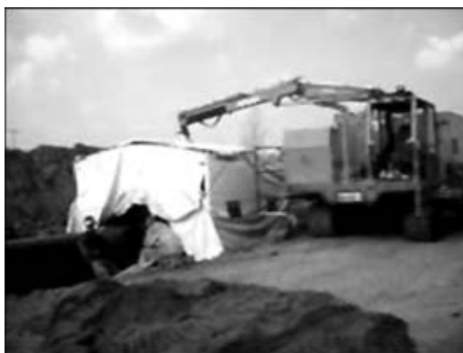
Рис. 2. Монтажная площадка для прокладки трубопровода
