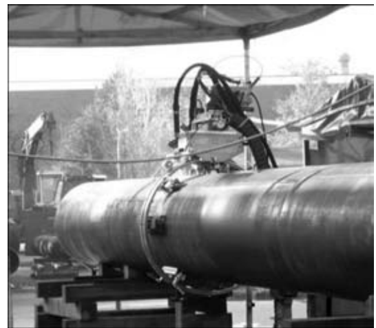
Рис. 8. Сварка труб с помощью установки опытной конструкции
