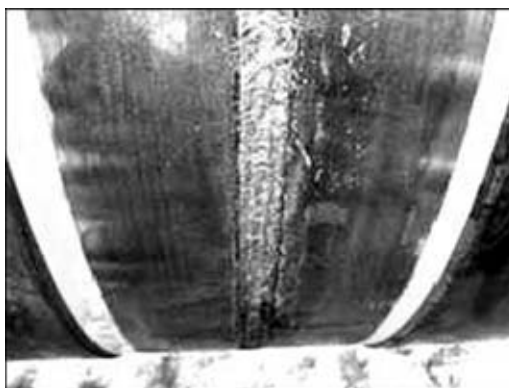
Рис. 1. Вид верхнего слоя шва, выполненного на трубе ручной дуговой сваркой
