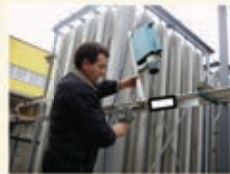
Размещение портативной Ф/Р аппаратуры на четырехточечном трубопроводе
