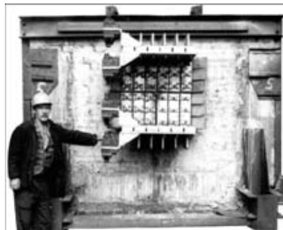
Рис. 1. Печь сопротивления на токи до 30 кА для синтеза карбида кремния
