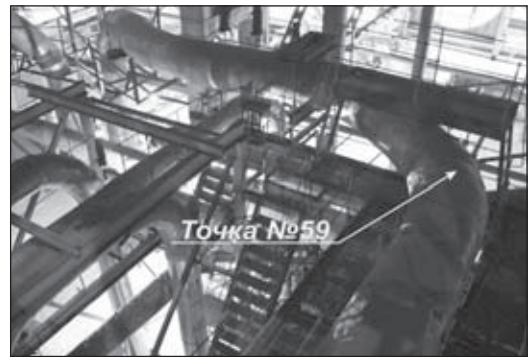
Рис. 19. Одна из точек измерения акустико-эмиссионной активности трубопровода промежуточного перегрева пара Киевской ТЭЦ-6
