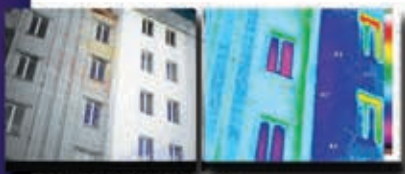
Видимое и тепловое изображение фасада жилого здания
