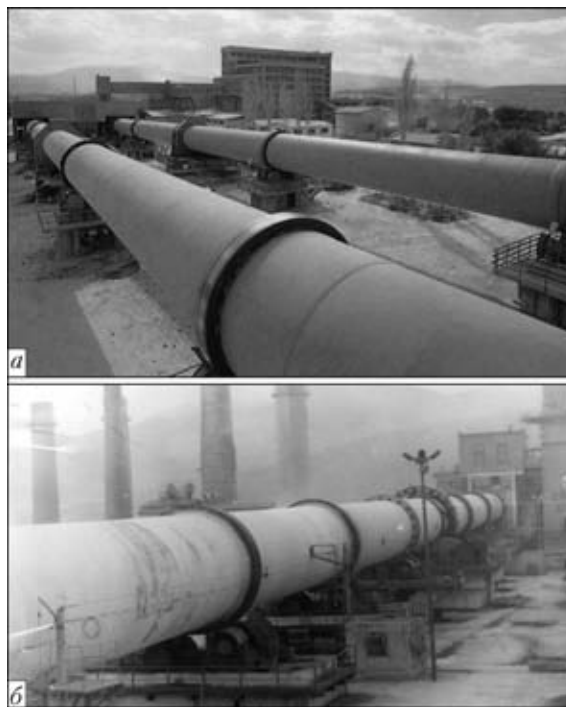
Рис. 1. Вращающиеся обжиговые печи диаметром 5×185 м с бандажами прямоугольного сечения, установленными на корпусе печи с радиальным зазором (а), и вварными бандажами фигурного сечения (б)
