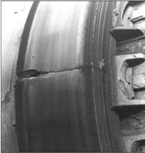
Рис. 2. Типичное разрушение бандажа вращающейся печи в результате образования сквозной поперечной трещины
