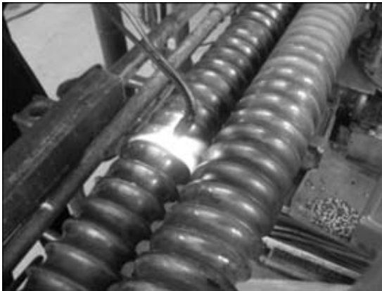
Рис. 9. Выполнение кольцевого незамкнутого нагрева газопламенной горелкой при тепловой правке шнекового вала
