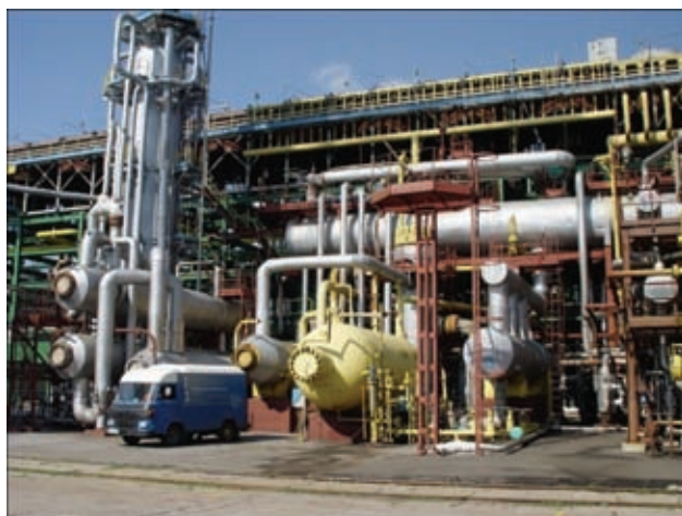
Рис. 2. Общий вид цеха производства аммиака ОПЗ
