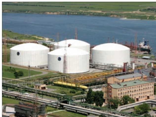
Рис. 1. Общий вид хранилищ аммиака ОПЗ
