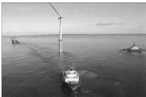
Рис. 5. Внешний вид первой свободноплавающей ветроэнергетической турбины фирмы «Siemens» и «StatoilHydro», установленной 8 сентября 2009 г. в Северном море
