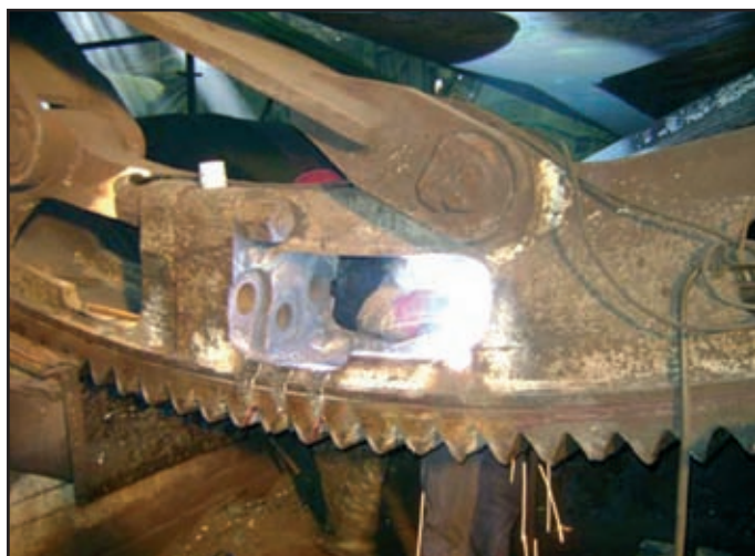
Восстановленный зубчатый венец обжиговой печи
