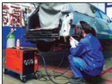
лько методом MIG-пайки. M 2070 CuSi успешно сваривает оцинкованные поверхности с помощью материала CuSi 3 диаметром 0,8 или 1,0 мм в защитной среде аргона. 4-роликовый подающий механизм и приспособленная сварочная горелка ML 1500 позволяют реально сваривать алюминий проволокой диаметром 1,0 мм. Аппарат отлично подходит также для сварки обычной или нержавеющей стали.
