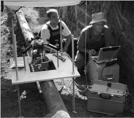
Рис. 14. Измерение уровня механических напряжений в теле трубы при шурфовом обследовании газопровода-отвода
