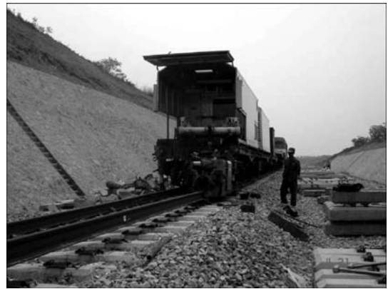
Рис. 7. Сварка рельсов передвижным комплексом К-922
