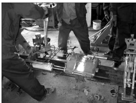
Рис. 5. Машина для алюмотермитной сварки
